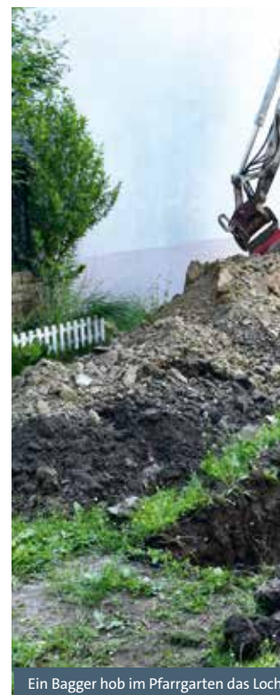
Ein Bagger hob im Pfarrgarten das Loch
